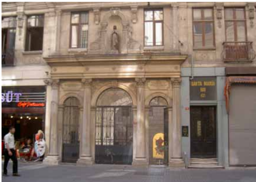
Pročelje zgrade Santa Maria han u ulici Caddesi na broju 431. Kip iznad prolaza, a kroz desni prolaz vidi se mozaik Uznesenja Marijina
