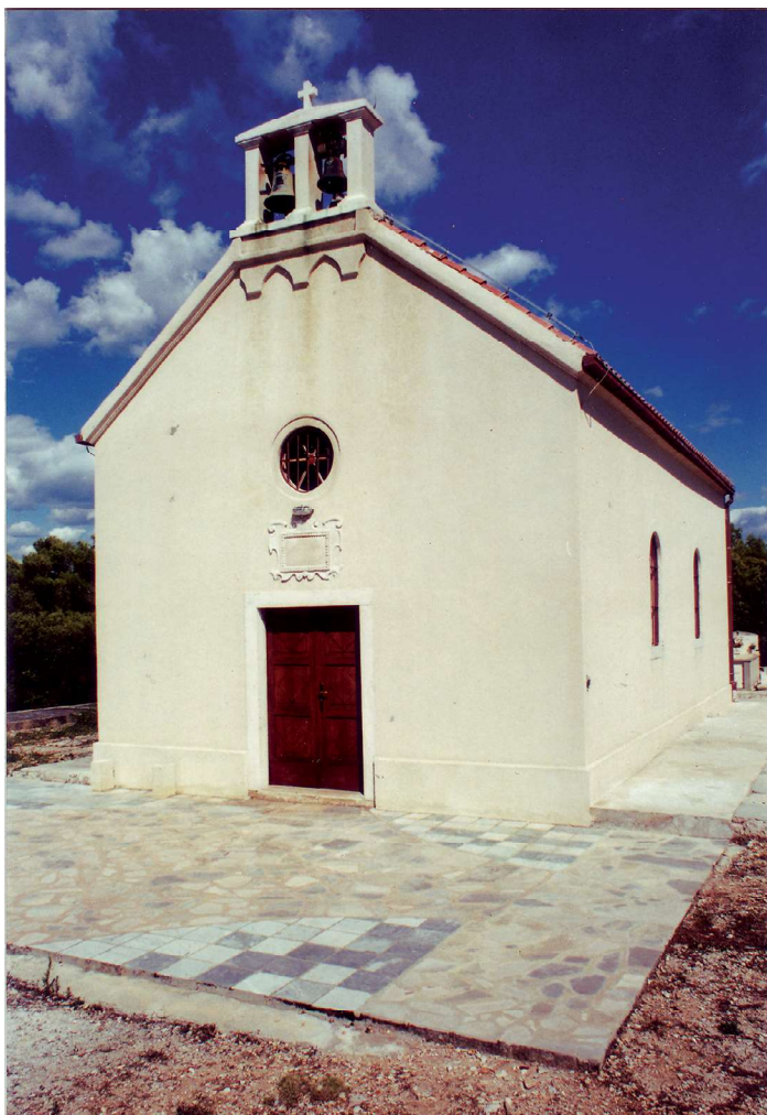
Vanjski izgled crkve Sv. Nikole nakon obnove
