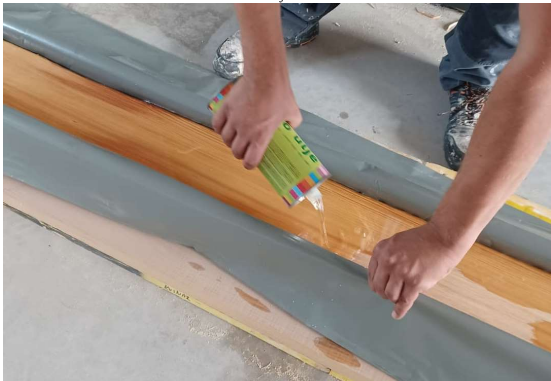
Slika 25. Zaštita drva lanenim uljem
