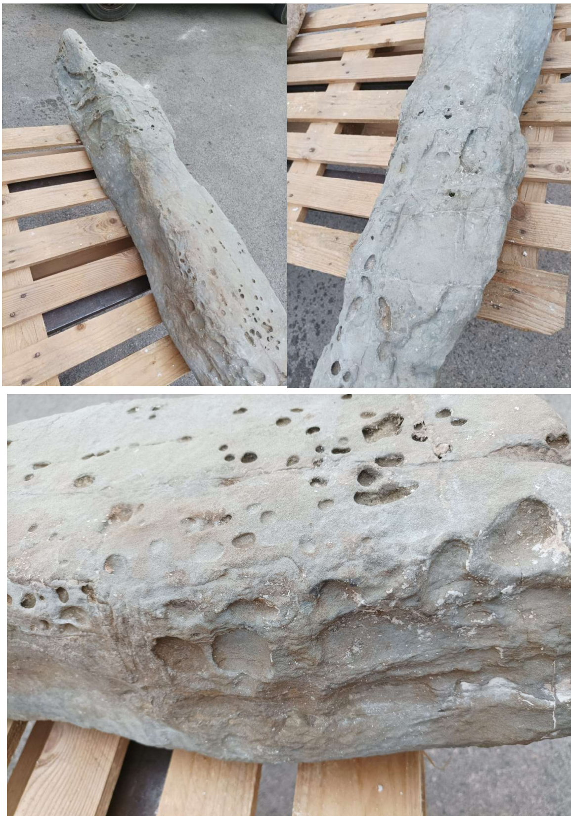
Slika 16. – 18. Izgled nakon toniranja rekonstrukcija
