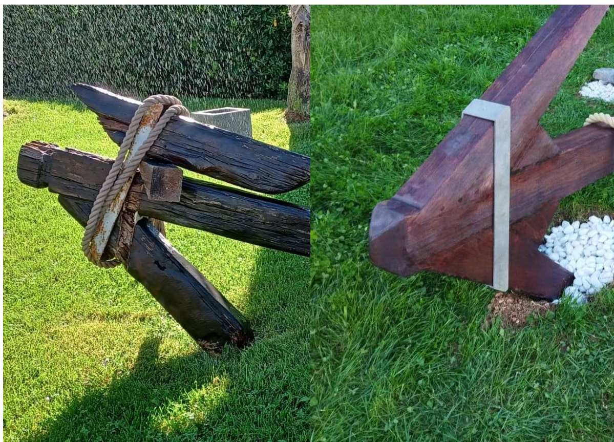
Slika 29./30. Zamjena metalne stega
