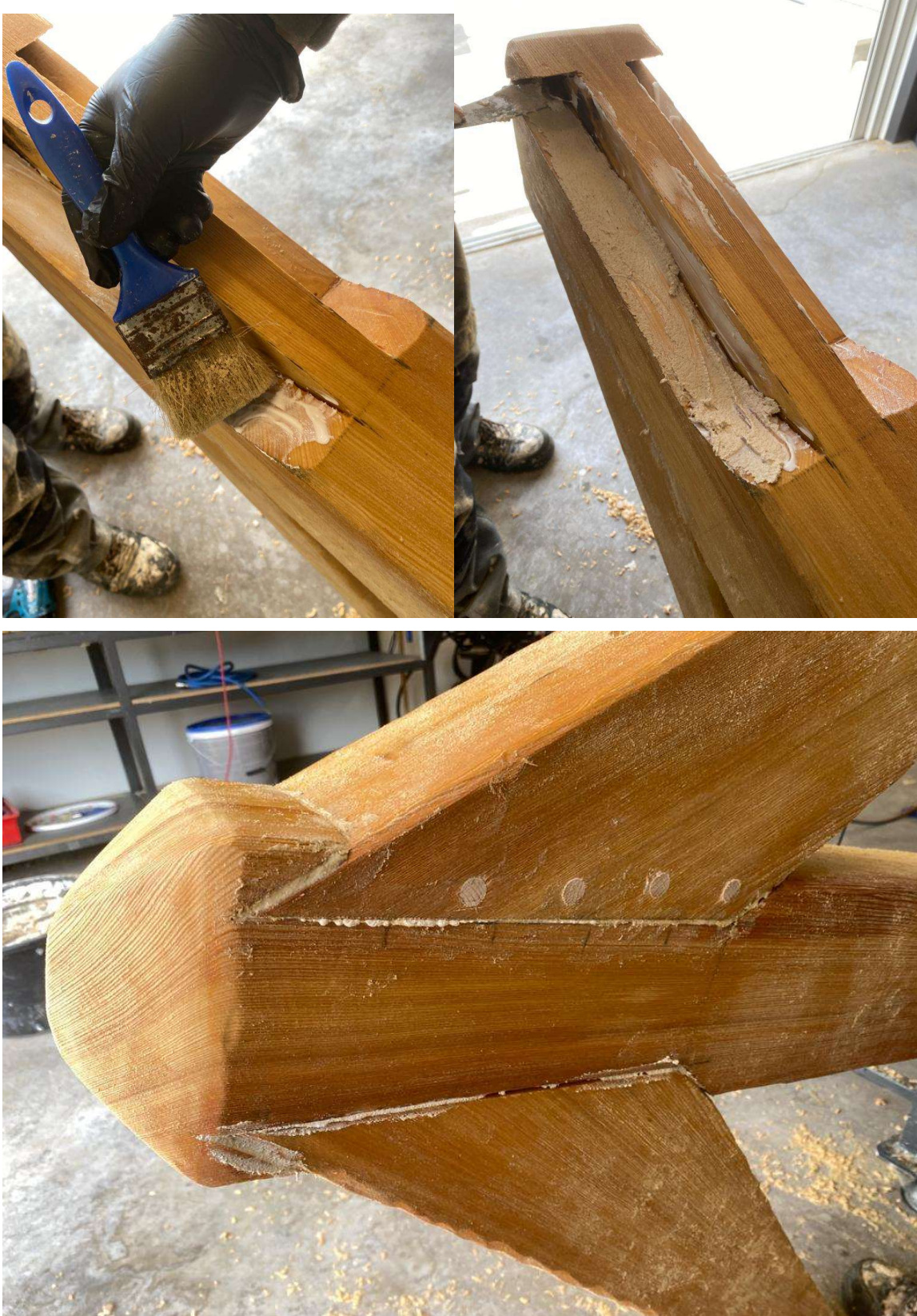
Slika 21. – 23. Lijepljene dijelova drva
