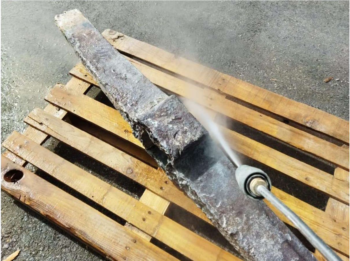
Slika 31. Čišćenje vodom pod pritiskom
