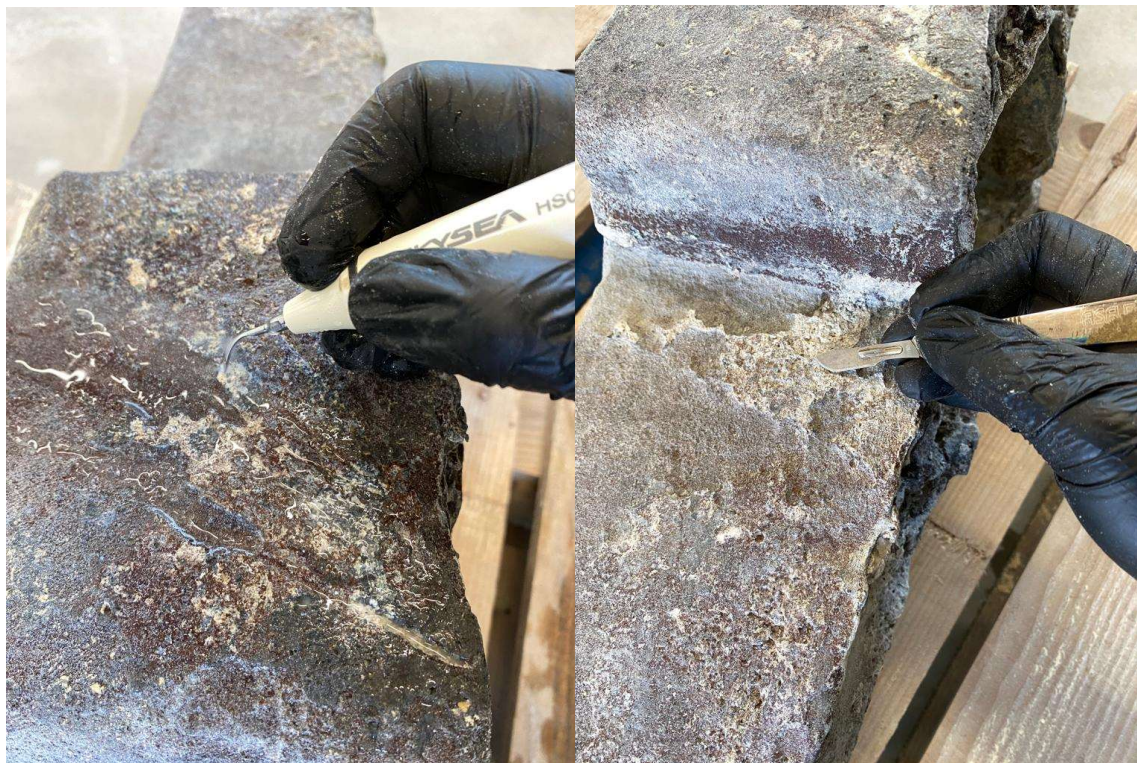
Slika 32./33. Mehaničko čišćenje
