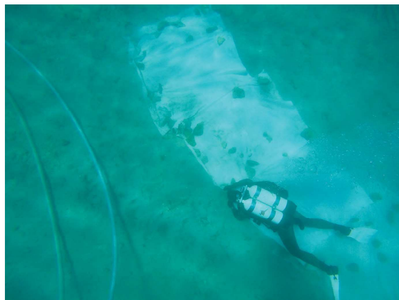
Prekrivanje brodske konstrukcije prvim slojem geotekstila (Foto L. Behić)
