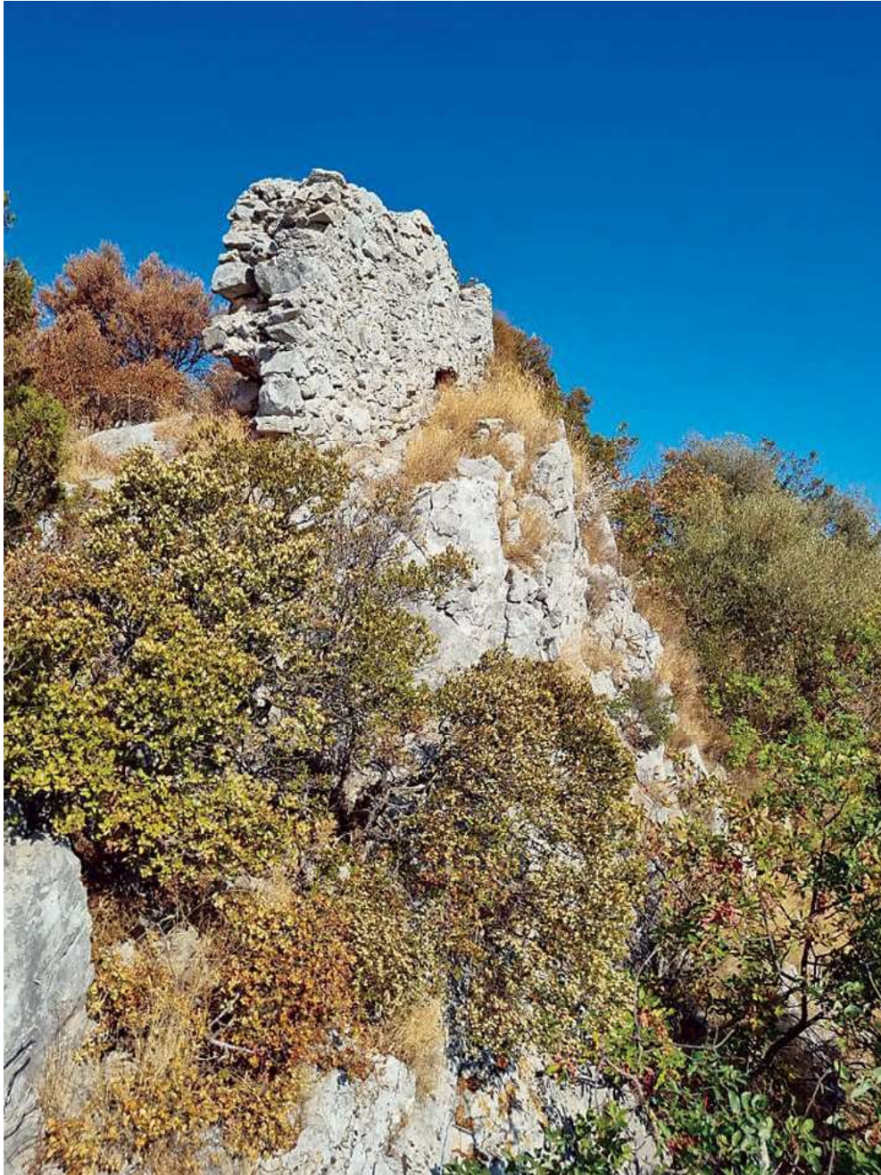
Slika 6. - Dio sjevernog zida.
