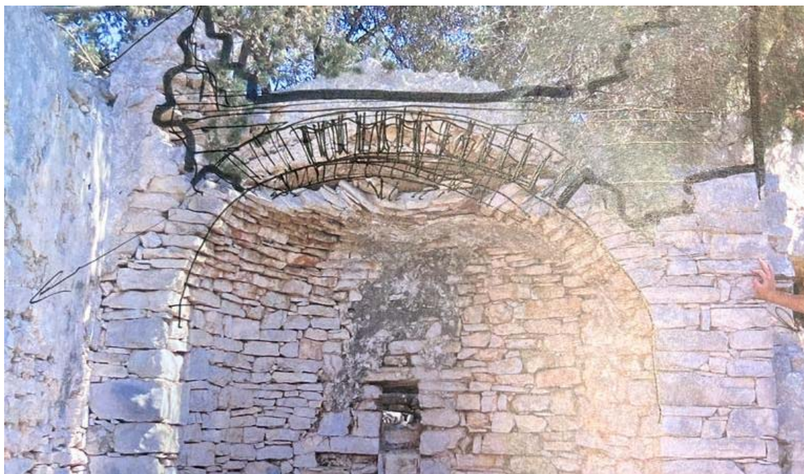
ostatak sjeverozapadnog zida i apsida
