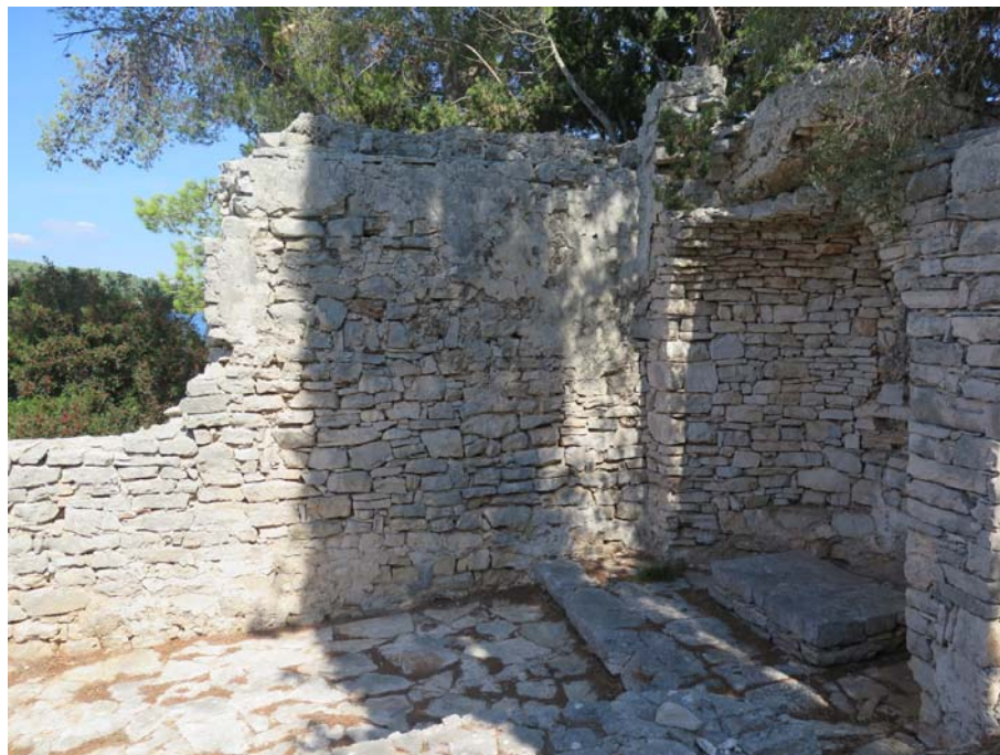
ostatak sjeverozapadnog zida i apsida
